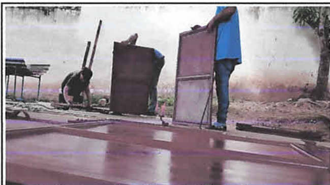
Foto 3: Mantenimiento a las ventanas de toda la escuela.
